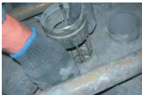
► Рис. 11. Монтаж ЗДЕСА-фильтрпатрона
