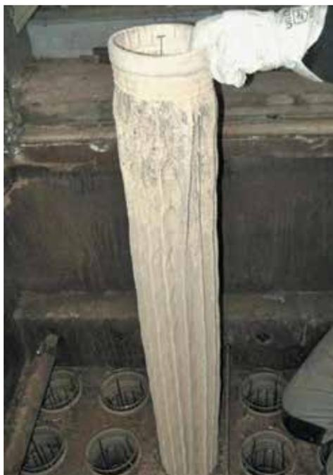
► Рис. 6. ЗДЕСА-фильтрпатрон в фильтре угольной электростанции
