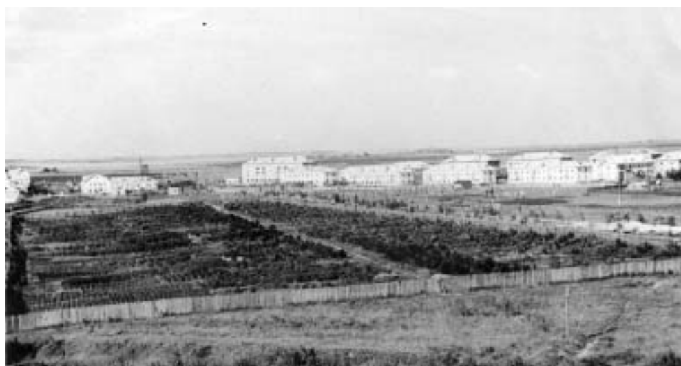
Панорама строящегося поселка
